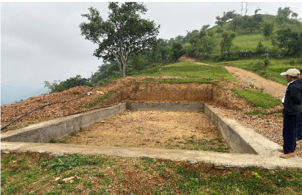
भूमिकास्थान-८ पोखेडाँडामा निर्माण गरिएको पोखरी
